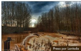
Presa por Lantada
